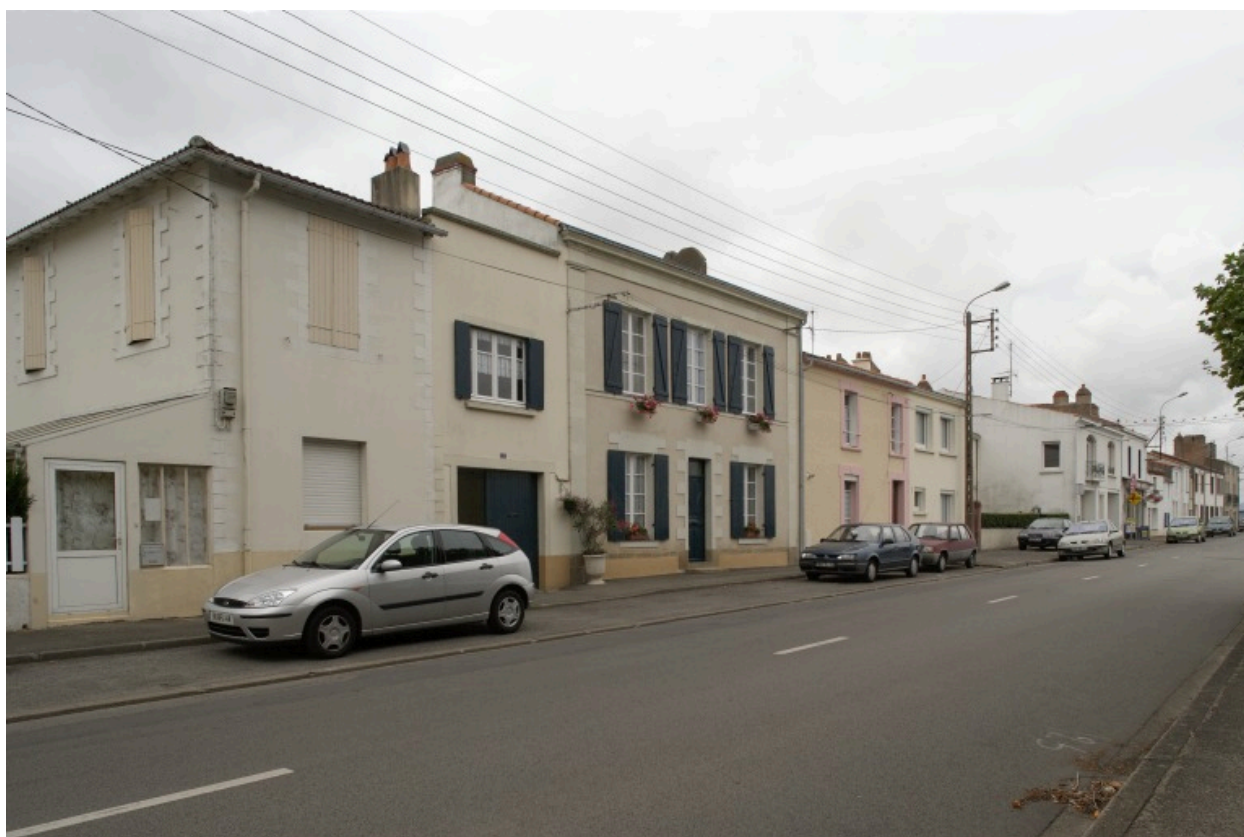
Vue d'ensemble du quai Edmond-Libert.
