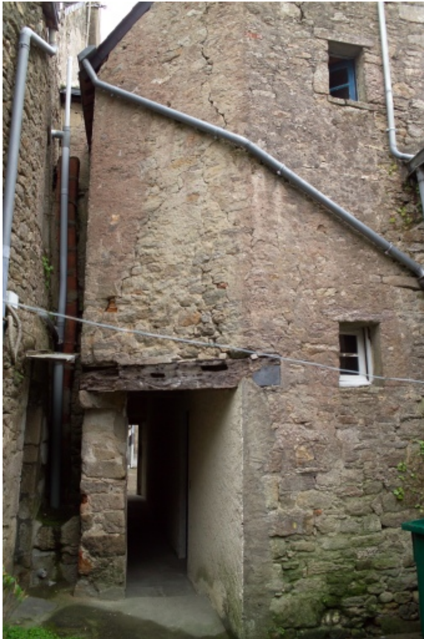
Vue de la tour d'escalier.
