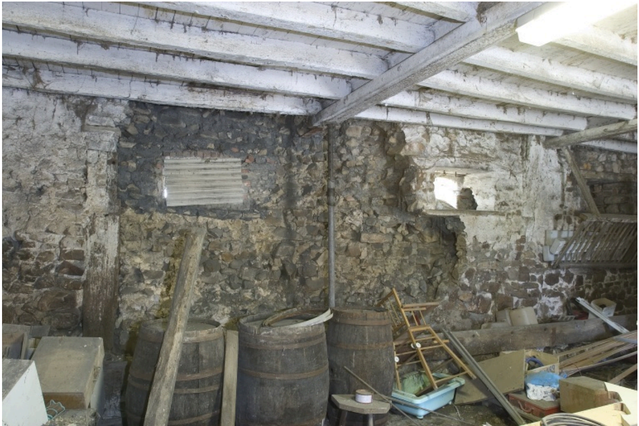
L'ancien logis-étable : le mur-gouttereau ouest de la partie étable.
