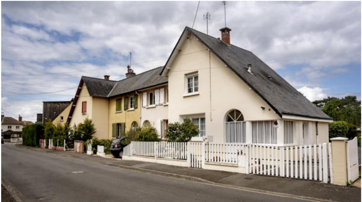
Vue d'un alignement de pavillons quadruples pour ouvriers de type C1.
