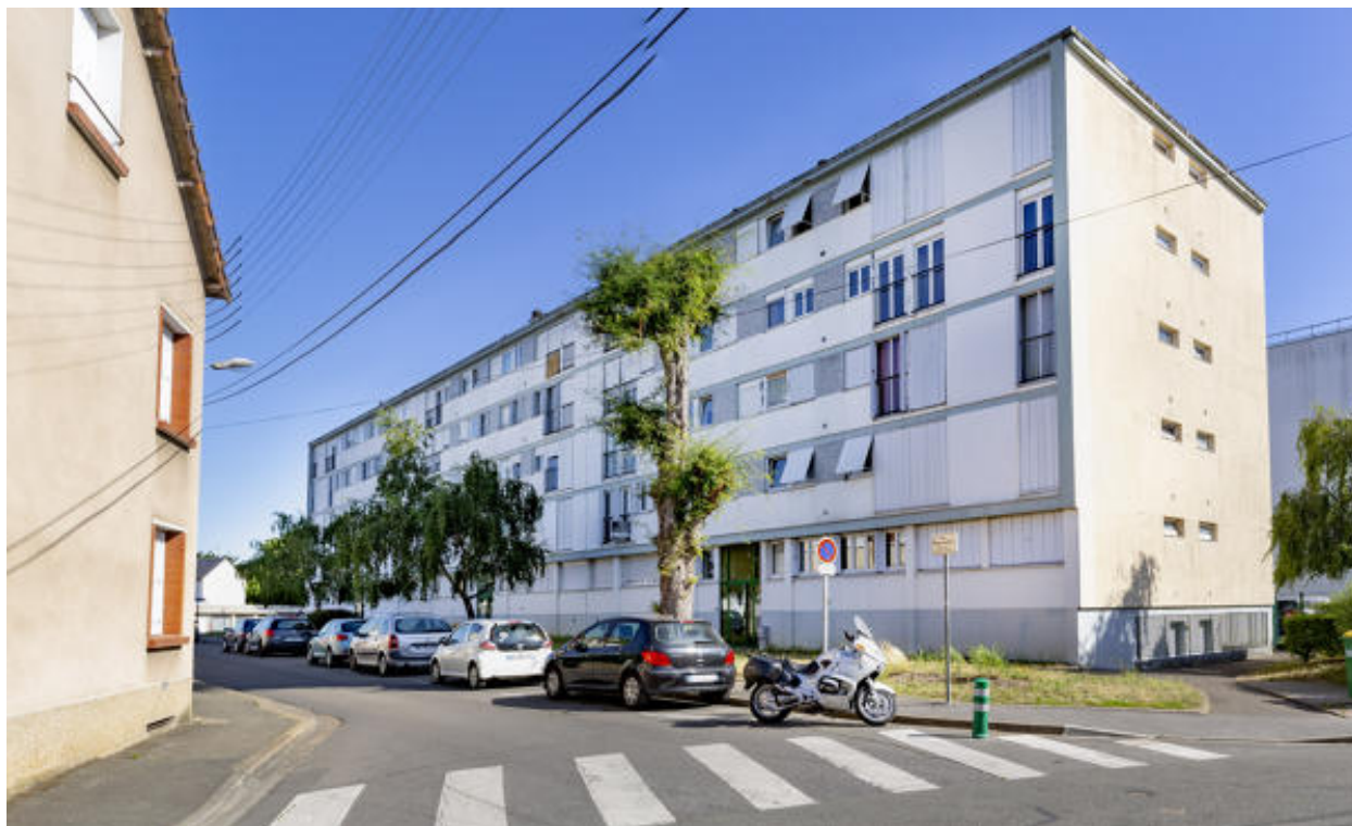
Vue d'un immeuble rue Amboise Paré.
