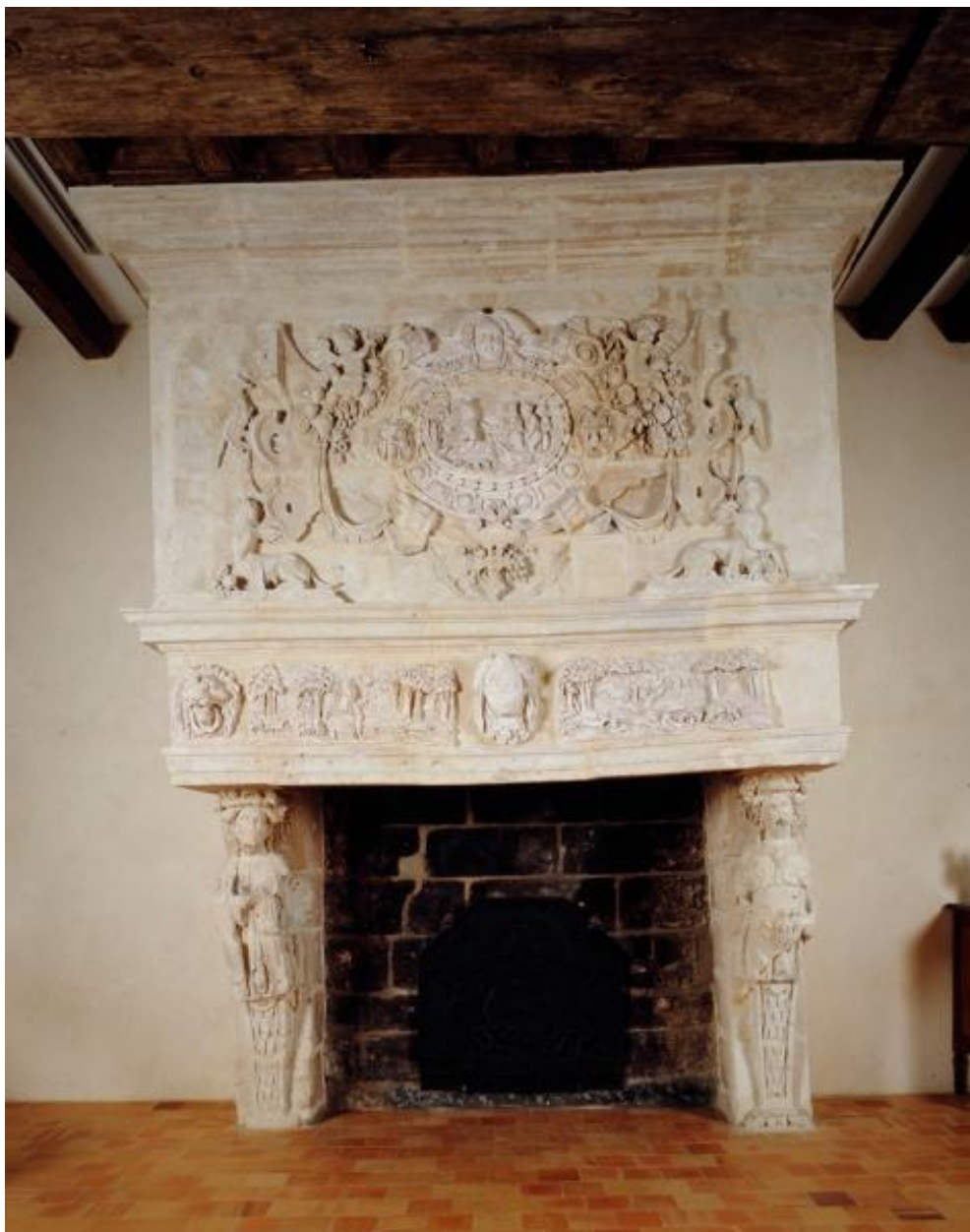
Cheminée sur mur nord au premier étage.
