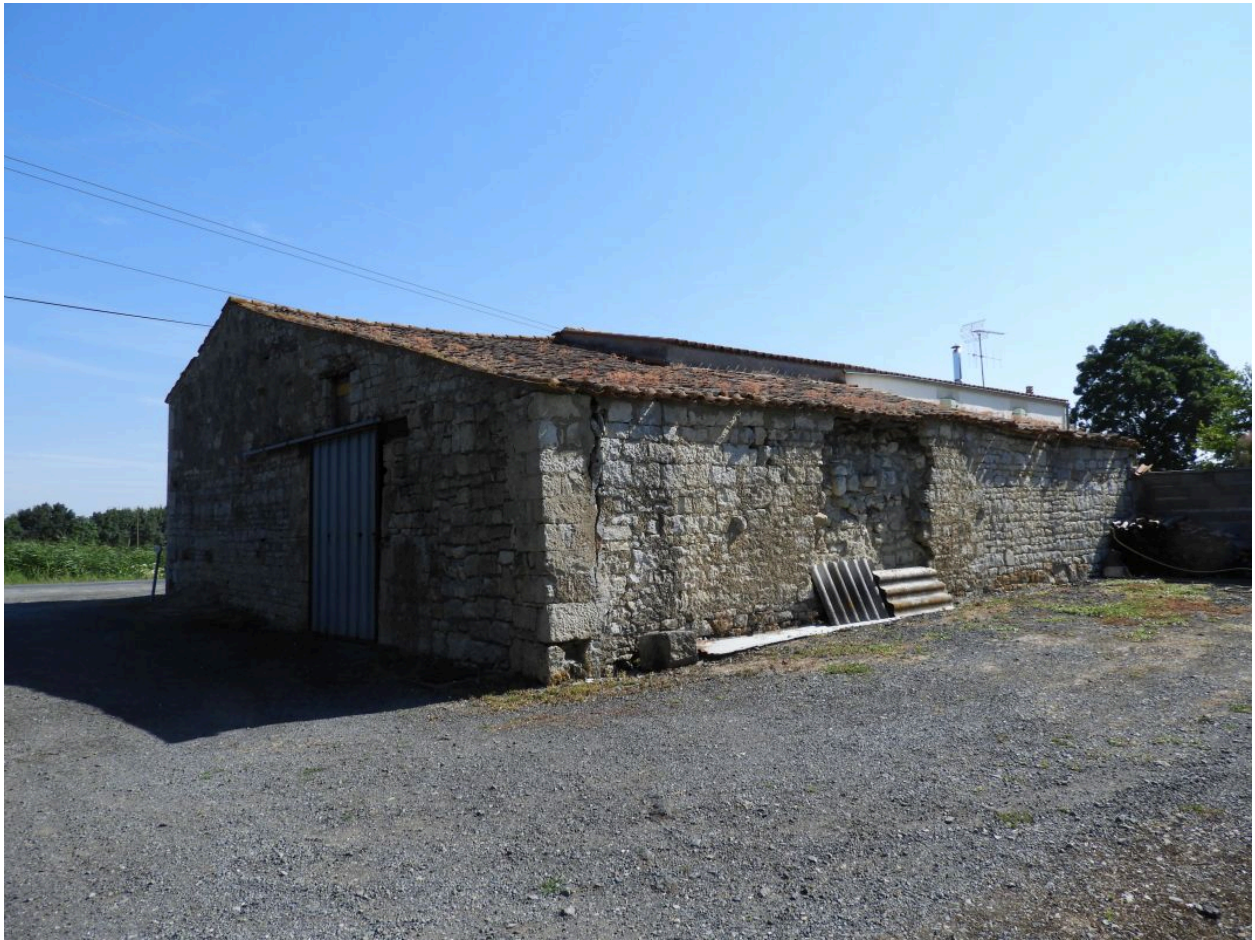
La grange-étable vue depuis le sud-ouest.
