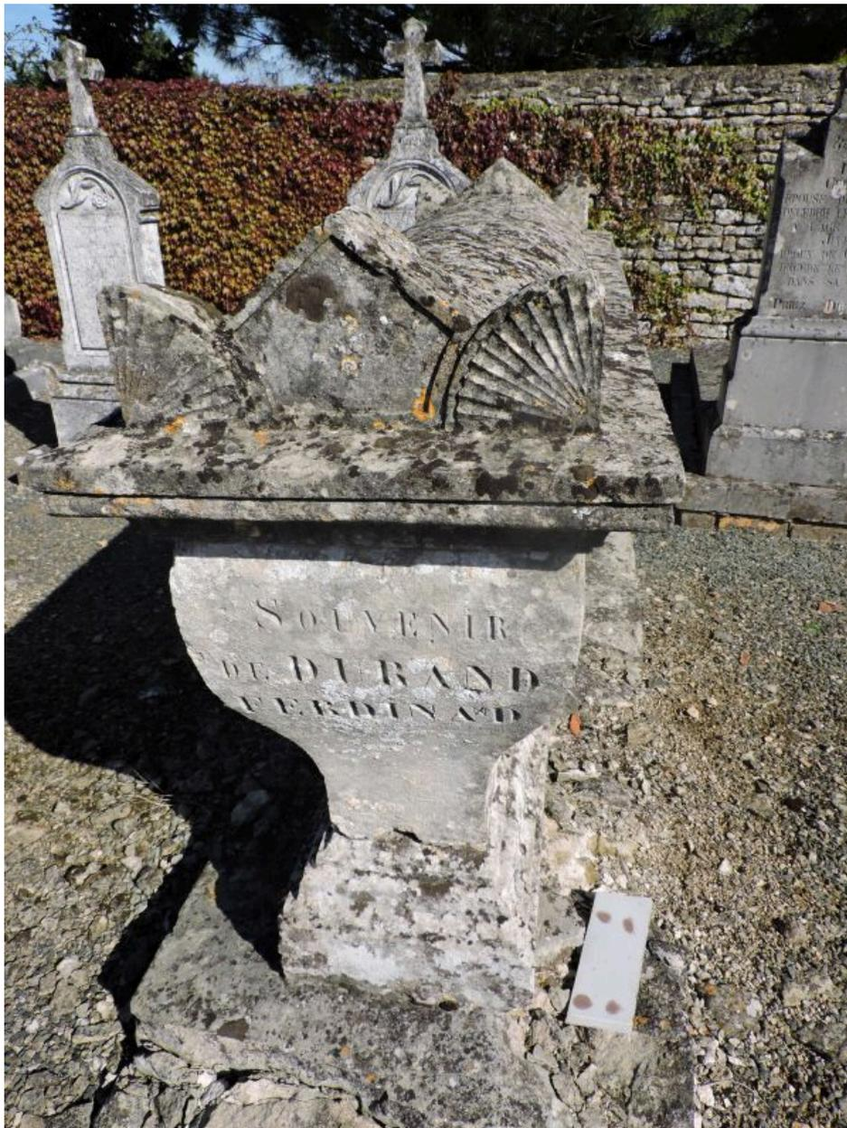
Vue latérale, avec fronton et mitres d'amortissement sur le couvercle.
