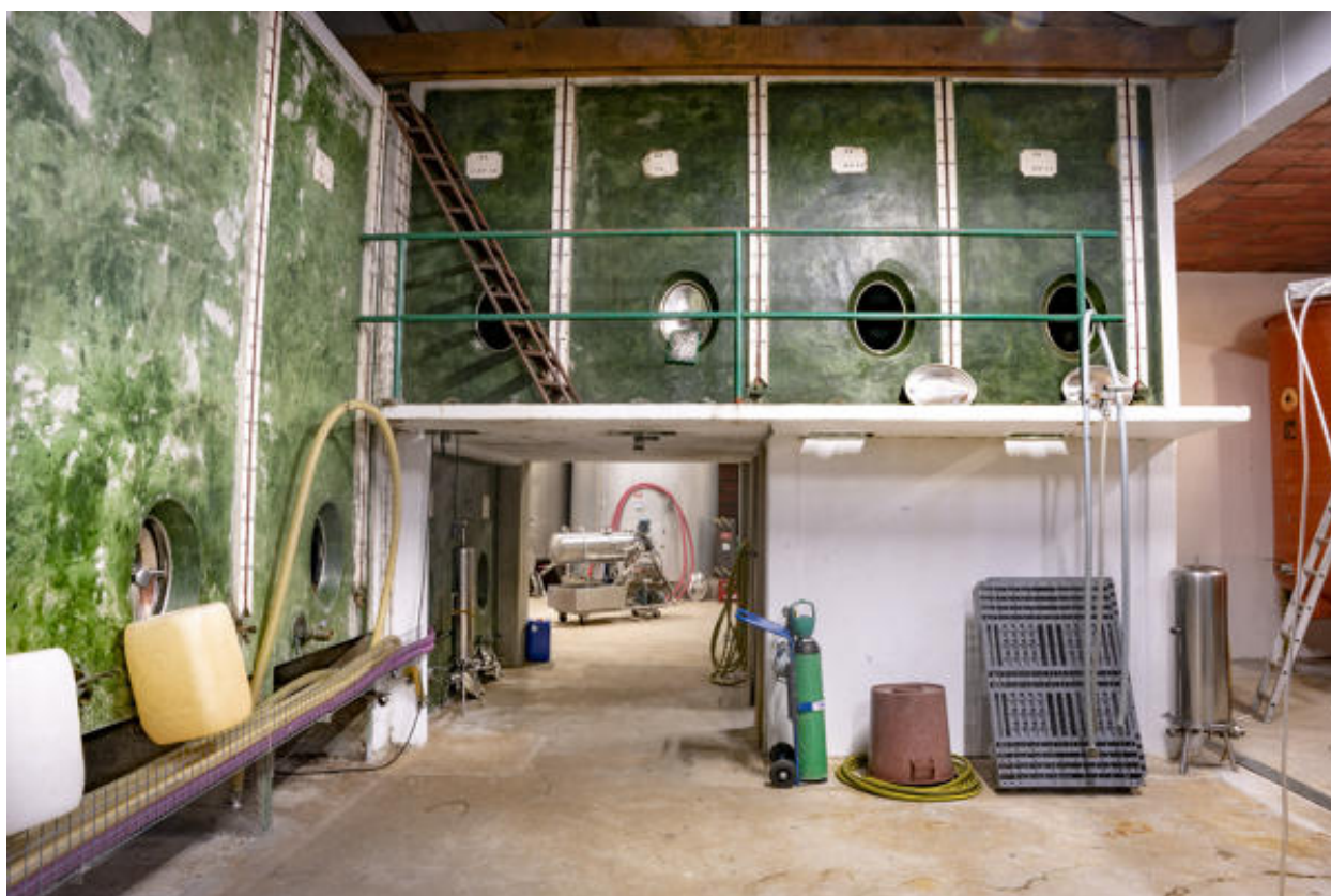
Cuverie principale, depuis le sud-est.
