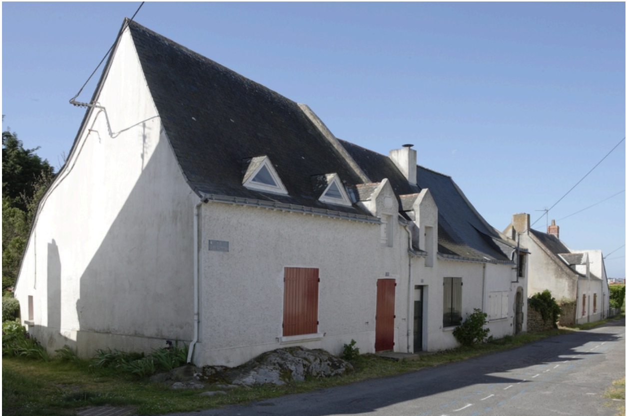
Vue d'ensemble de la rangée depuis le nord-est. Au premier plan, le n° 1 rue des Carmes.
