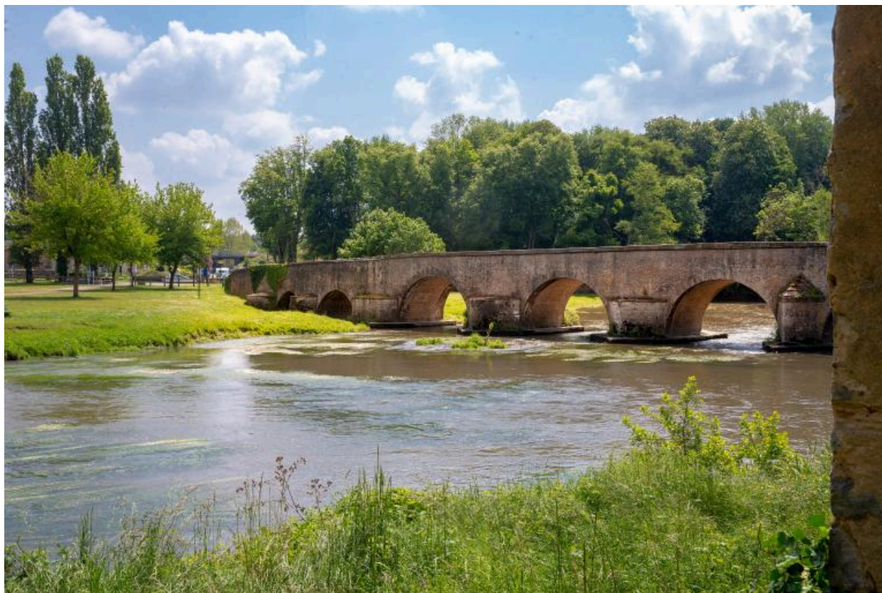
Le pont, face nord.
