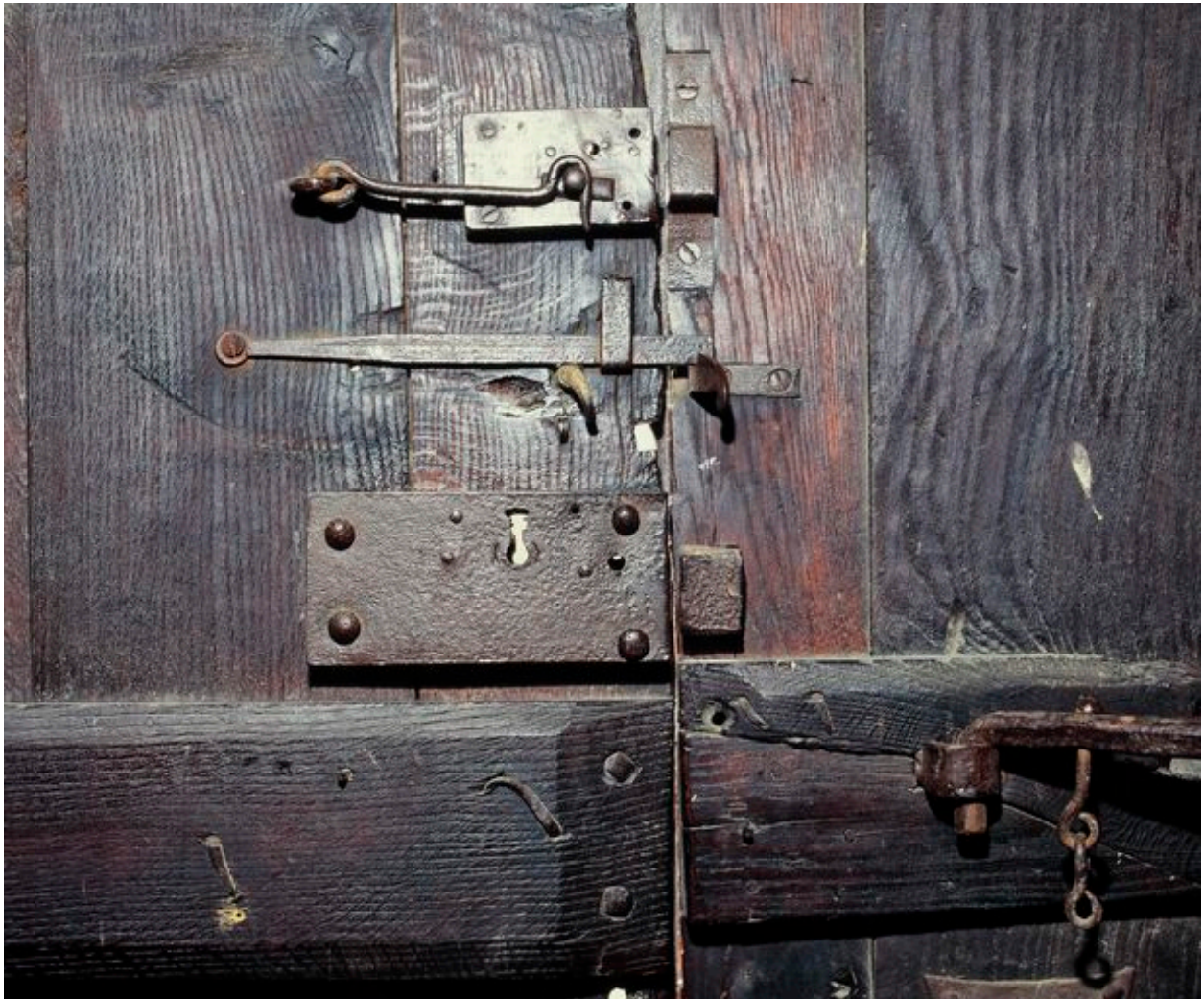
Huisseries (fin XVIIe ou XVIIIe siècle ?). Entrée sur rue, porte bâtarde, revers sous le passage couvert, détail des ferrures et serrure (1).
