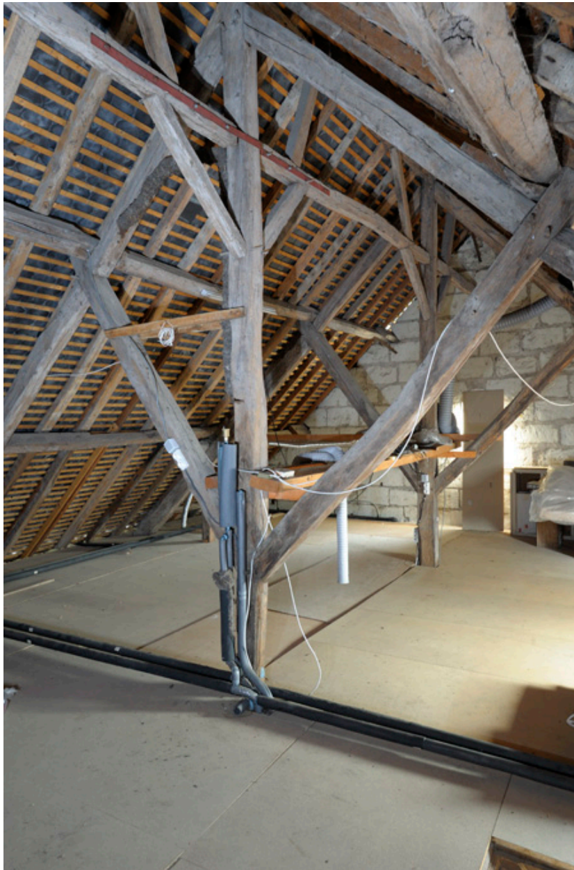
Corps est, comble. Charpente avec fermes à contrefiches.
