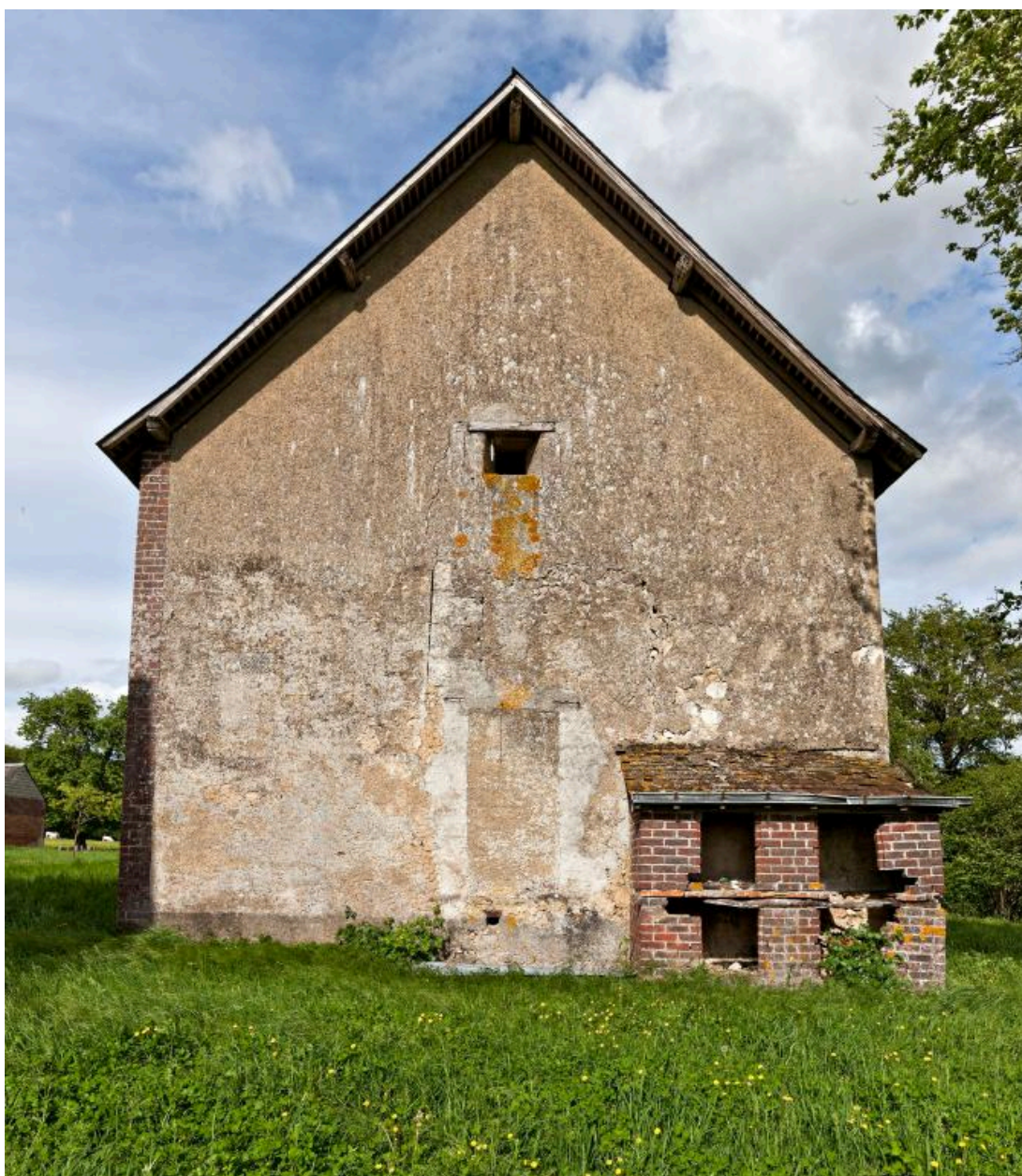
Clapiers à lapins en briques accolés à l'étable.
