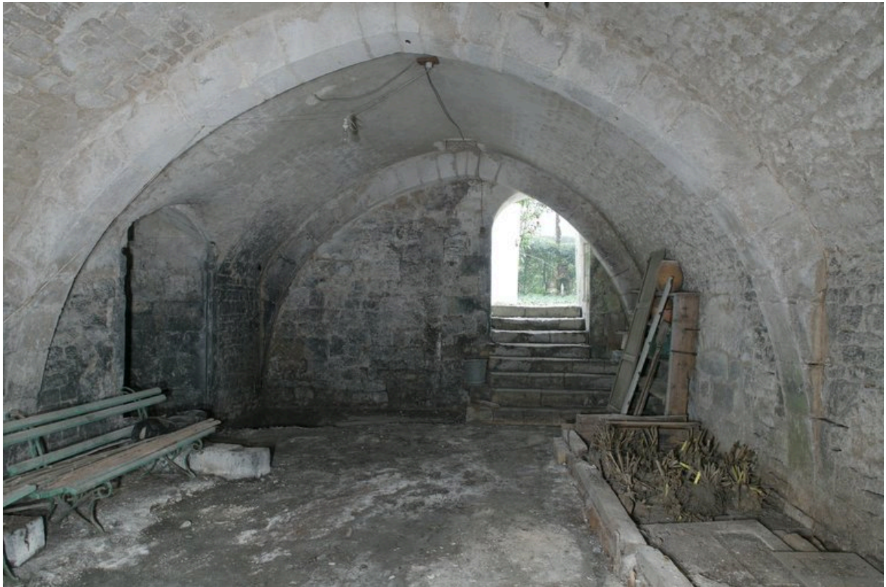
Bâtiment des archives : vue du sous-sol, prise en direction de l'entrée.
