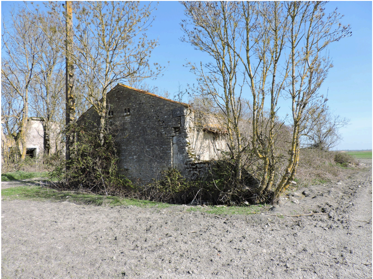
La seconde grange au sud, vue depuis le sud.
