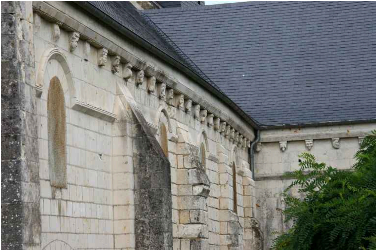
Mur sud de la nef : modillons.
