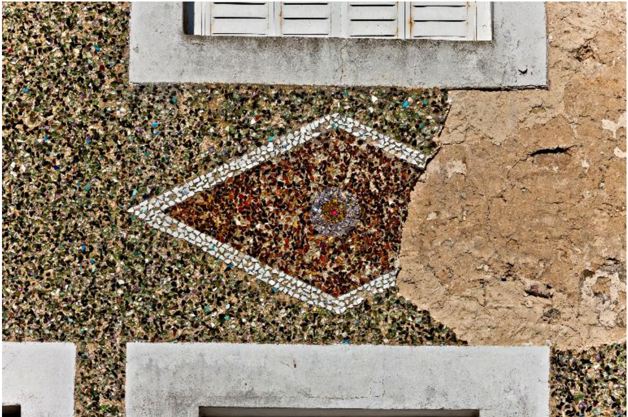
Détail du motif central de l'enduit de la maison droite.
