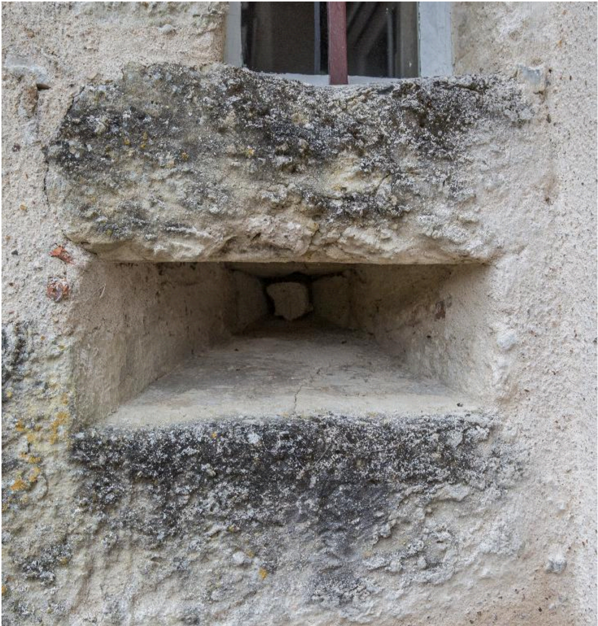
Pavillon nord-ouest : bouche à feu sud.
