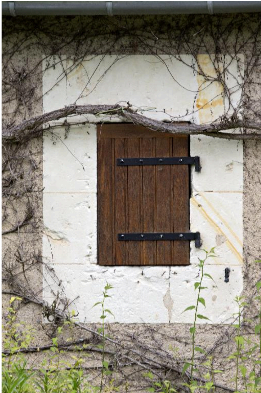
Petite baie à droite de la porte centrale.
