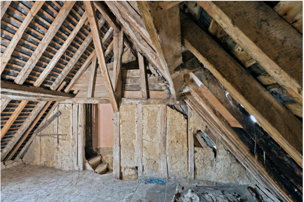
Maison 1, comble : pignon ouest.
