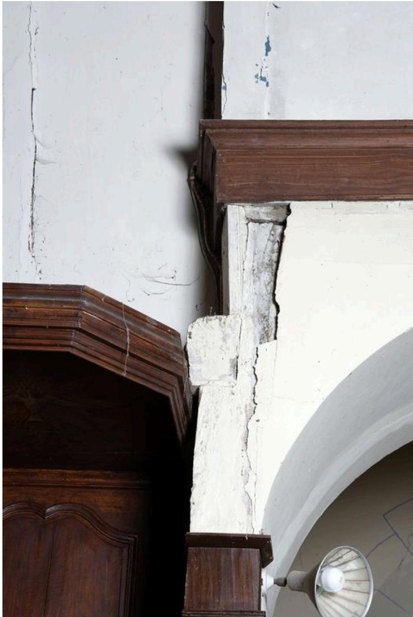
Poteau inclus dans la maçonnerie du mur nord à l'entrée de la nef : il devait supporter la poutre de gloire..
