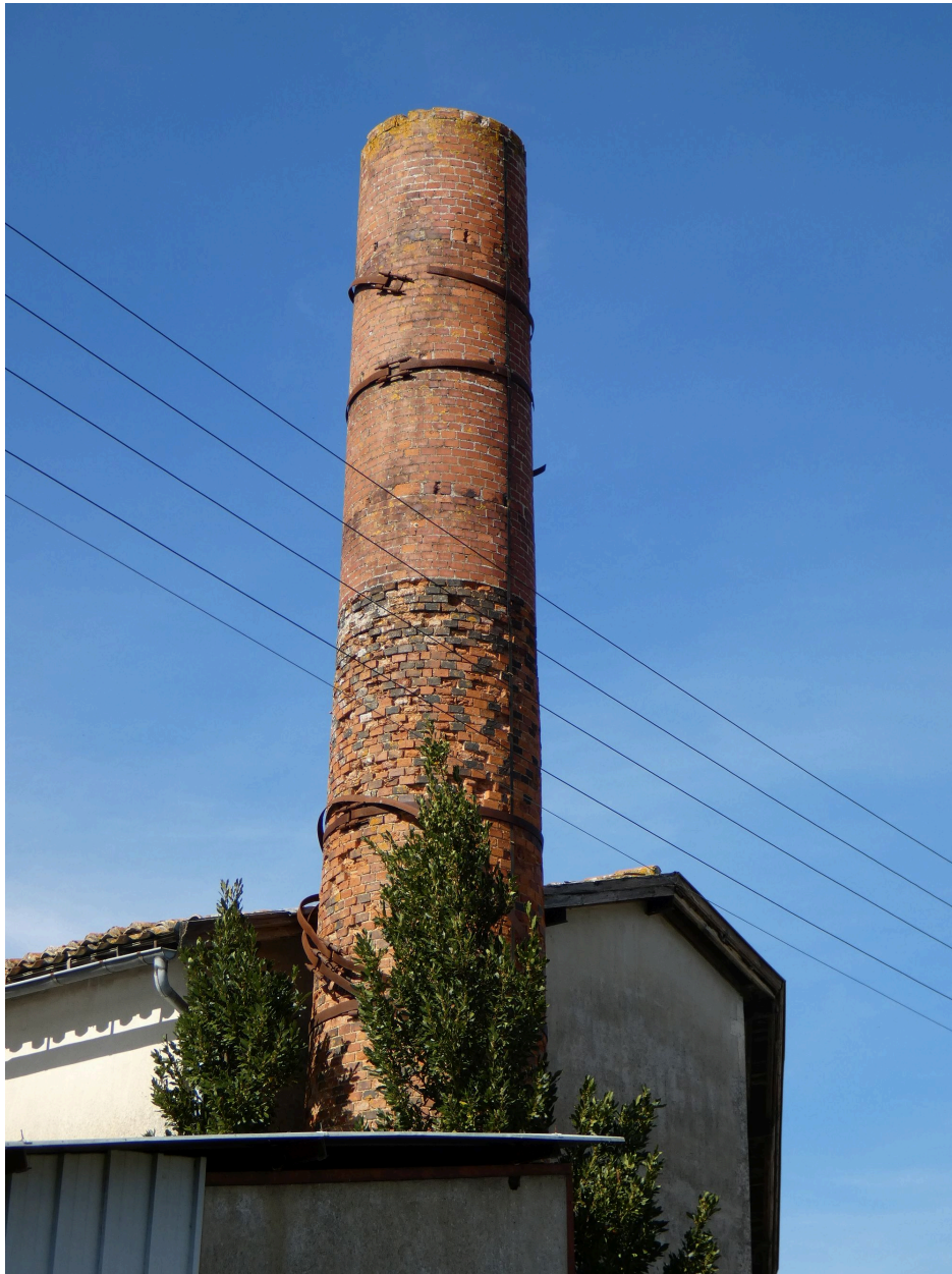
La cheminée vue depuis le sud.
