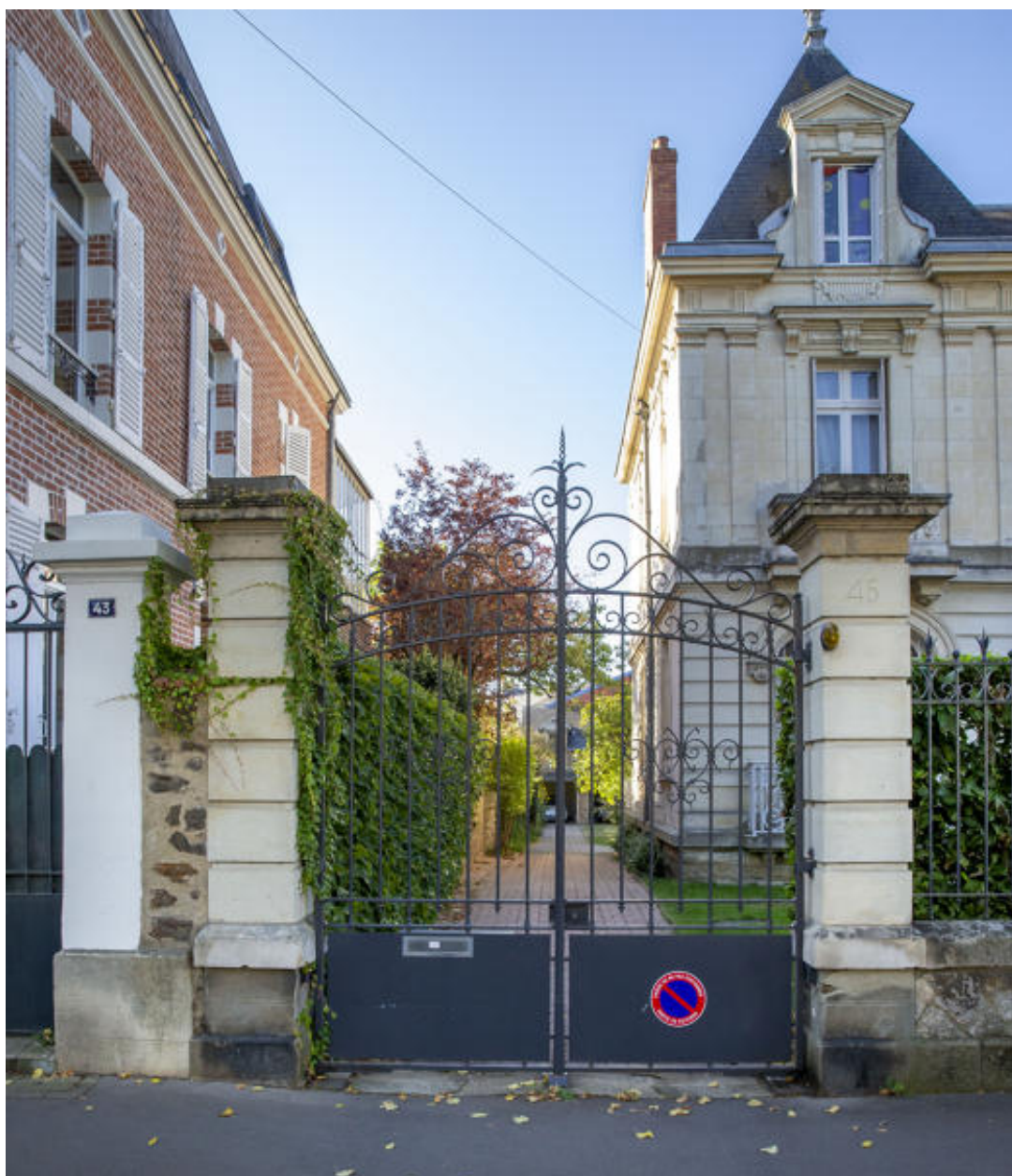
Vue de l'entrée depuis le boulevard.
