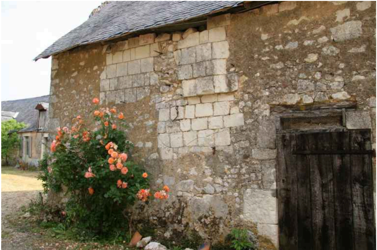
Mur droit de la nef : détail de maçonnerie.
