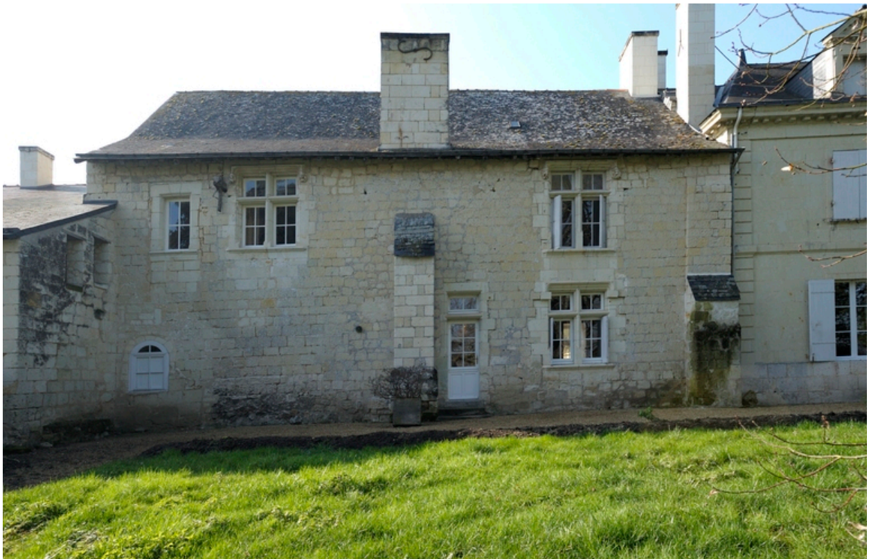
Logis. Manoir médiéval, façade nord.
