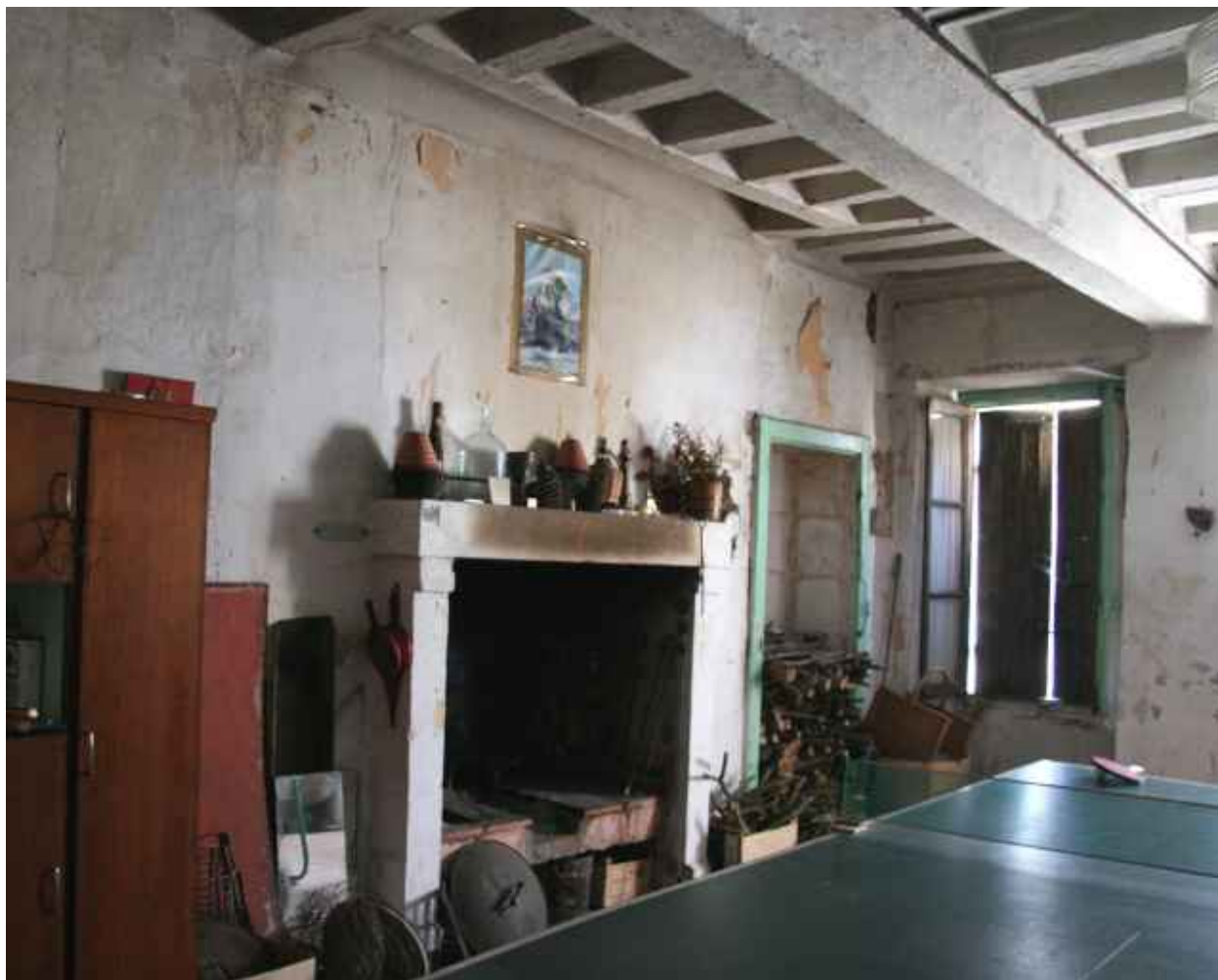
Rez-de-chaussée : la salle à cheminée.
