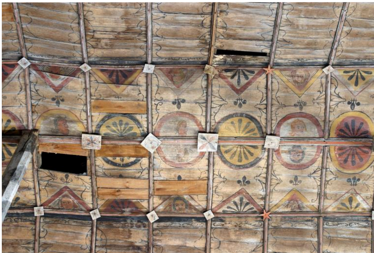
Nef, voûte, côté sud, deuxième travée, registre de faîte : vue d'ensemble.
