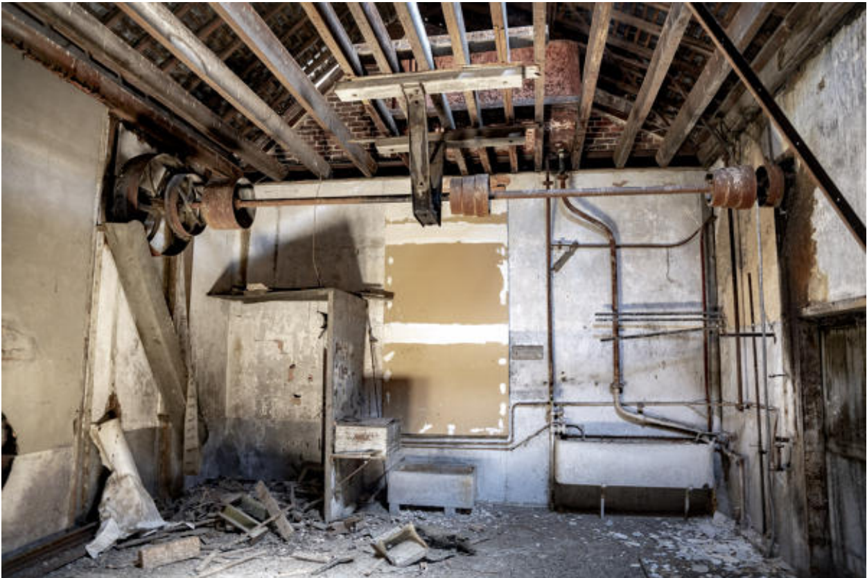
Vestige du système de transmission du bâtiment D.
