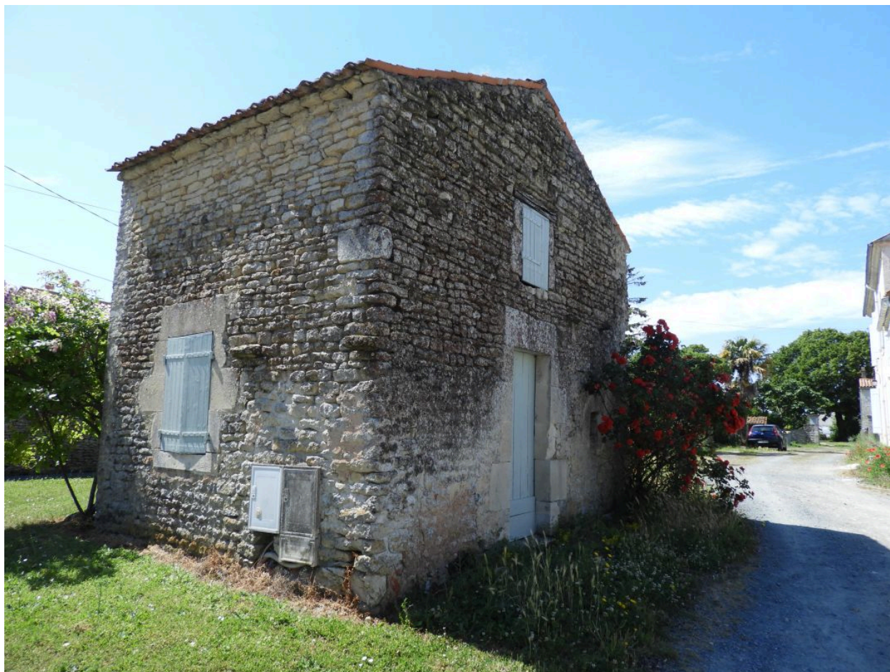
La remise vue depuis le nord.
