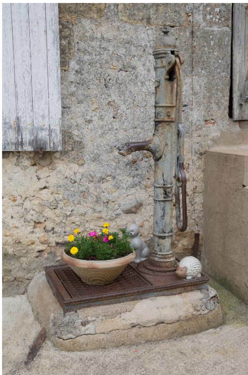
Pompe à eau devant l'habitation.
