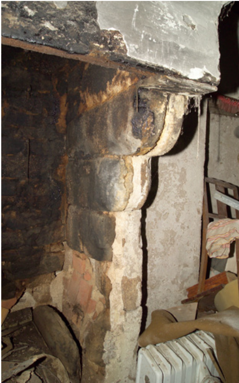
Corps principal, rez-de-chaussée, pièce orientale, cheminée, détail du montant droit.
