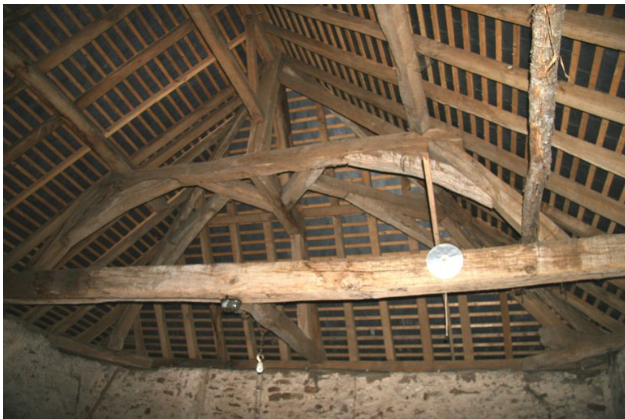
La grange : charpente.
