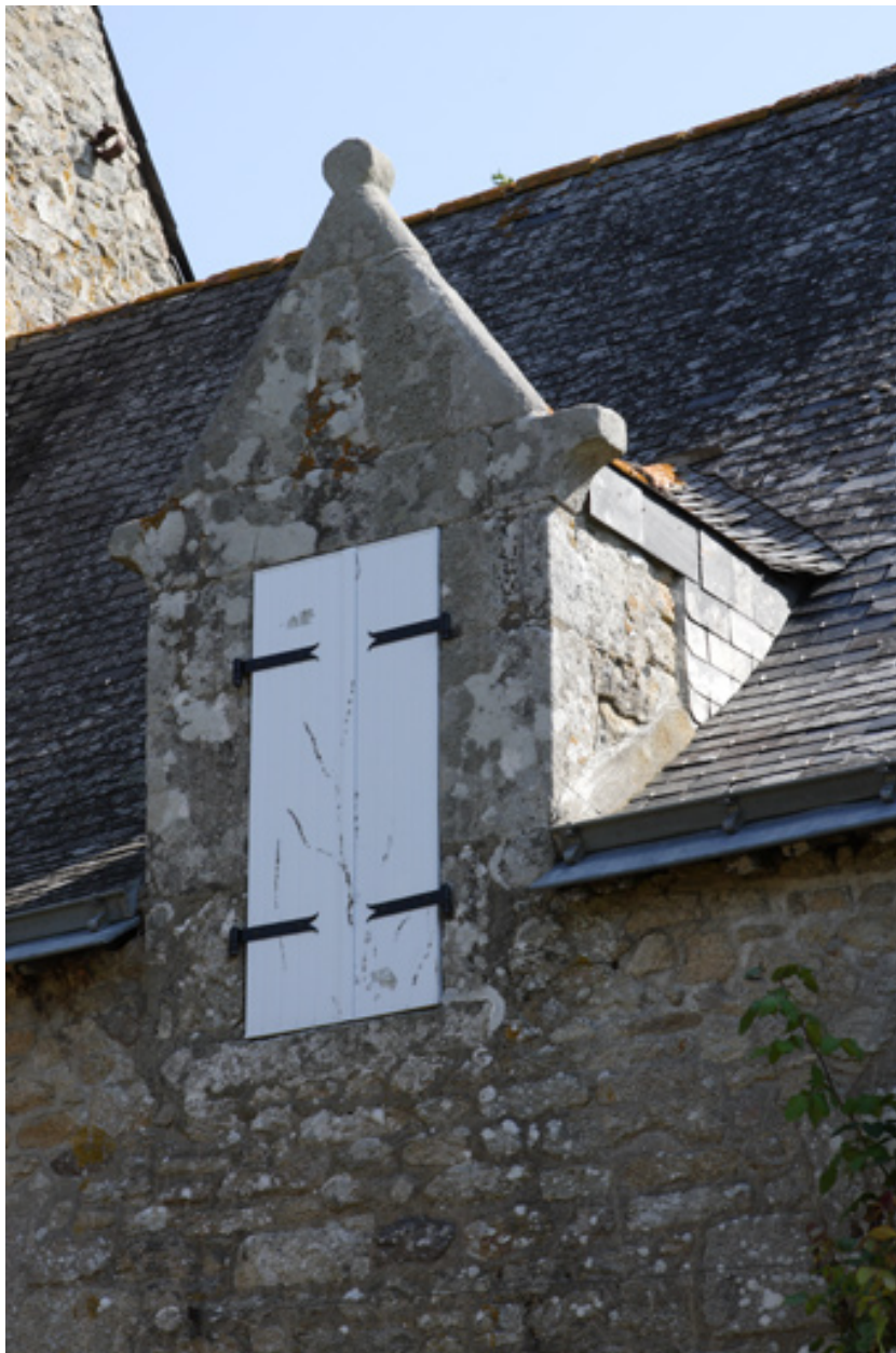
Aile nord. Façade est. Lucarne.
