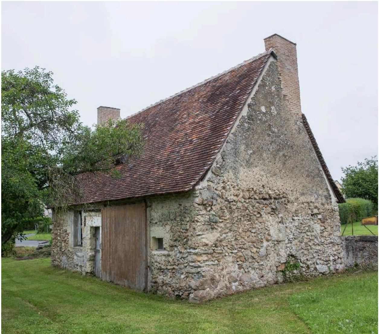
Vue de volume (façades sud est est).
