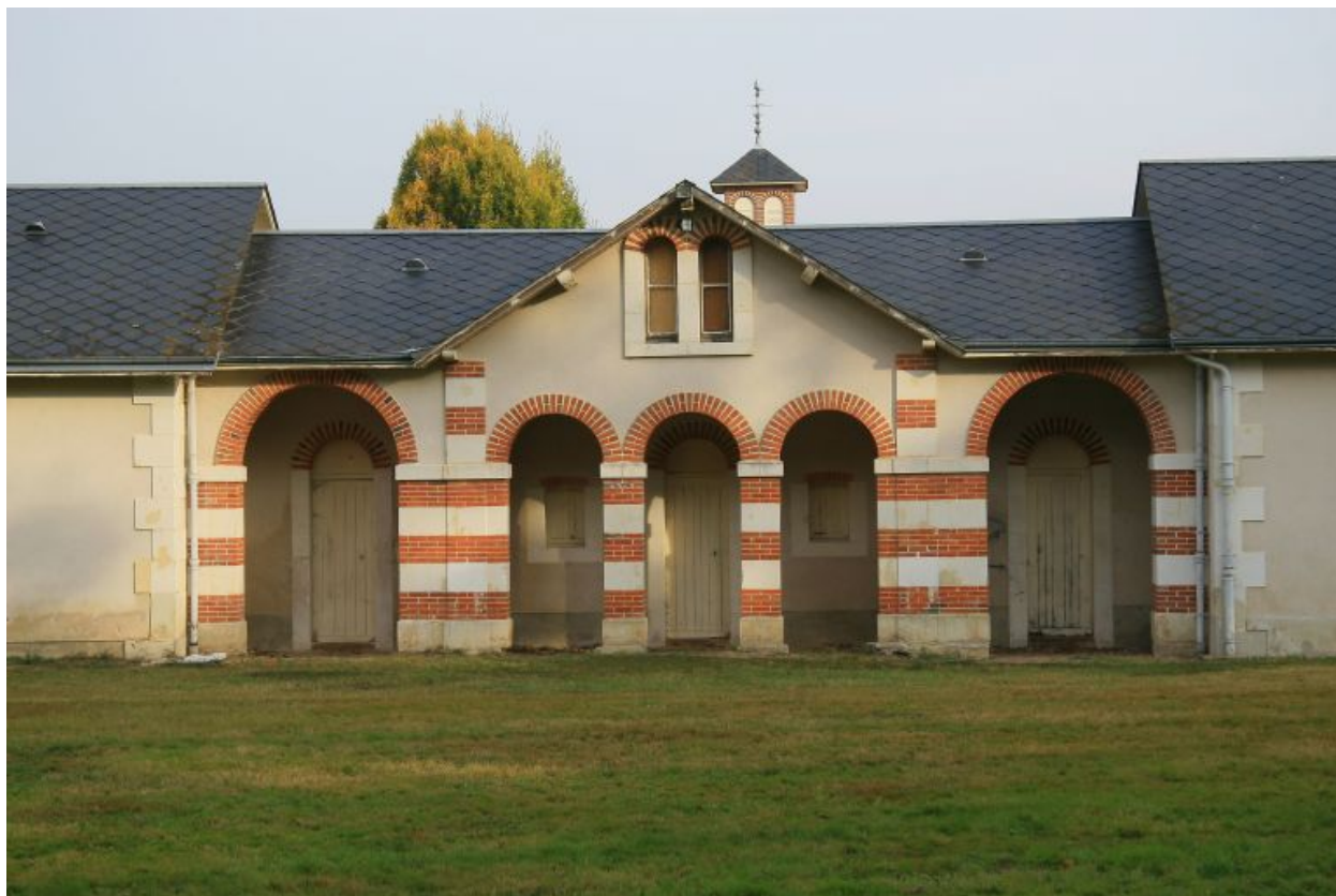
Les communs, façade sud : détail.
