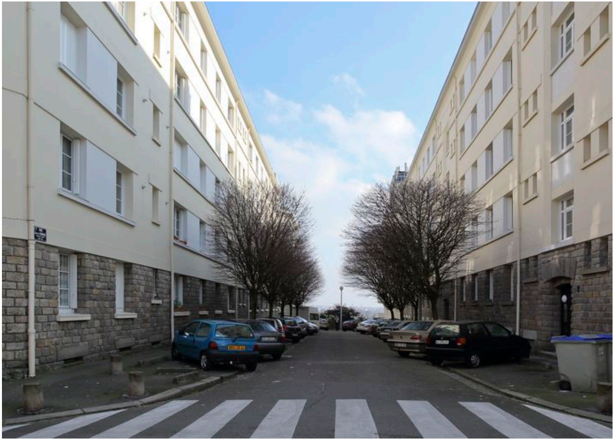
Rue entre les bâtiments B et C.
