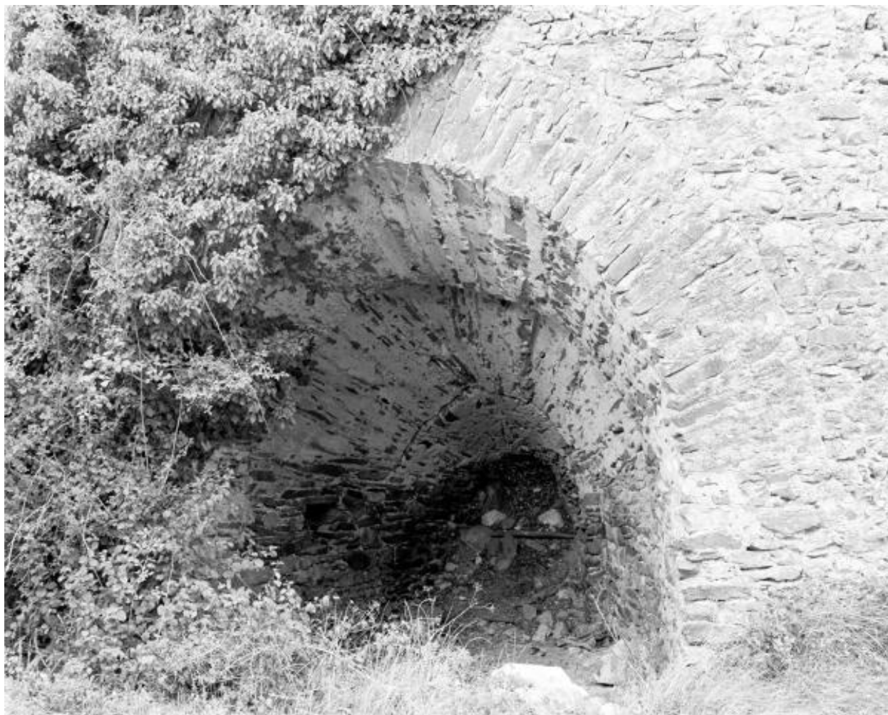
Masse de four en tour à enveloppes concentriques, ébraisoir sud, four à chaux du Lièvre, Montjean-sur-Loire.
