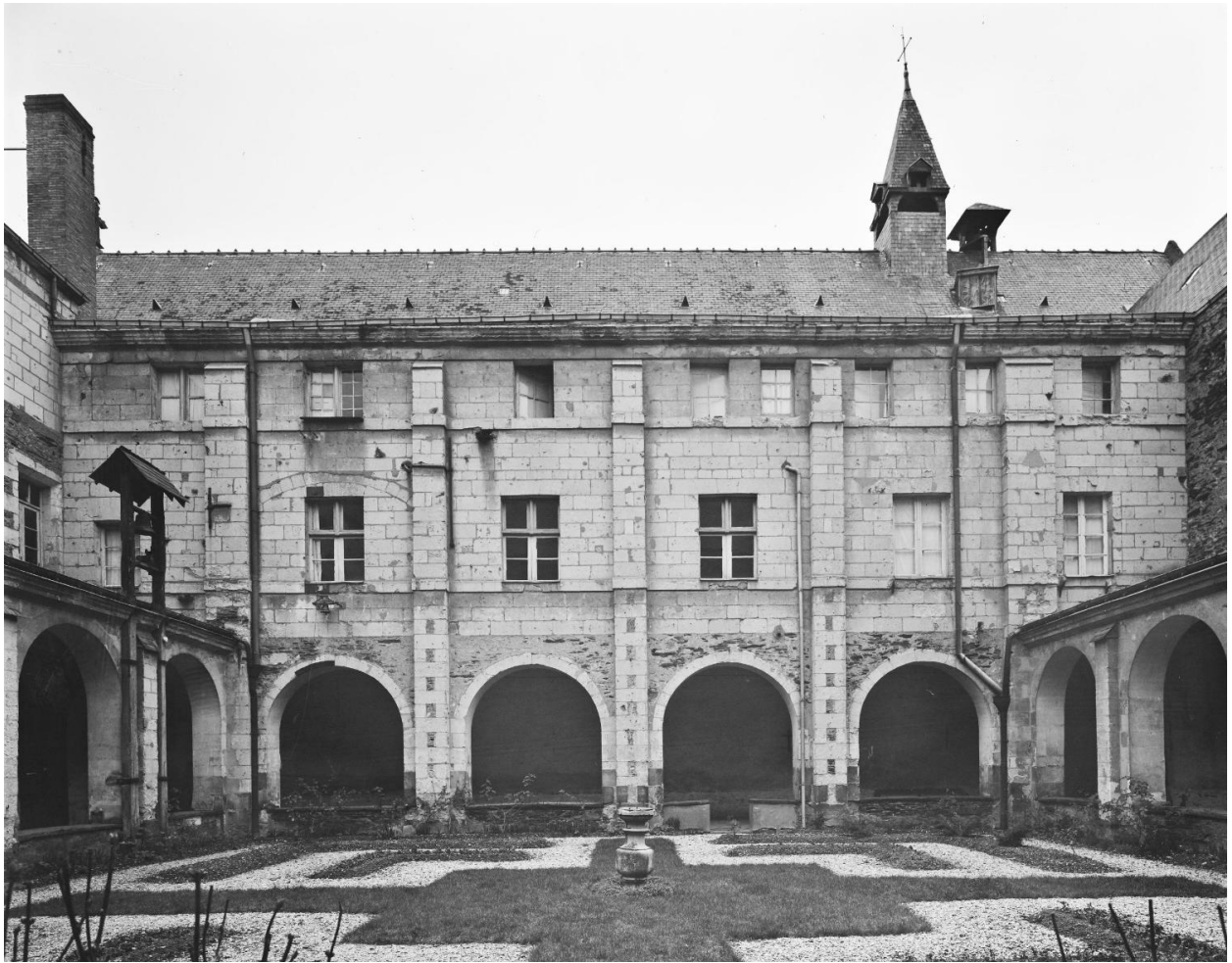
Cour du cloître : aile ouest (contre l'église).
