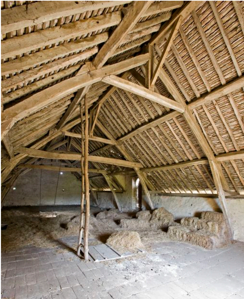
Le Mortier Noir, vue intérieure du fenil
