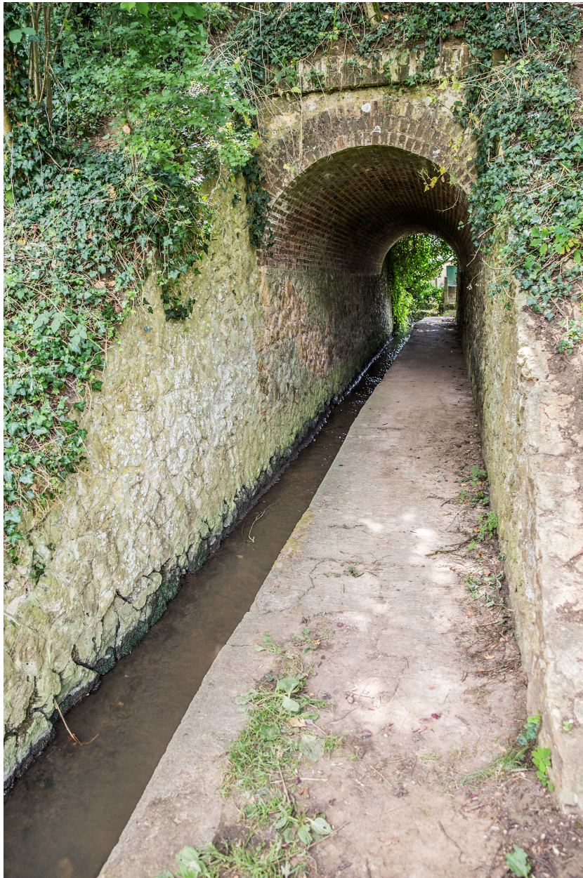
Un ponceau de l'ancienne voie ferrée sur le Gué-aux-Anes, rue Frédéric Joliot Curie.
