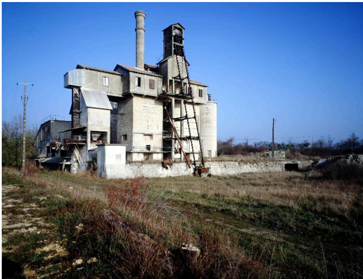
Usine de chaux : vue d'ensemble sud-ouest
