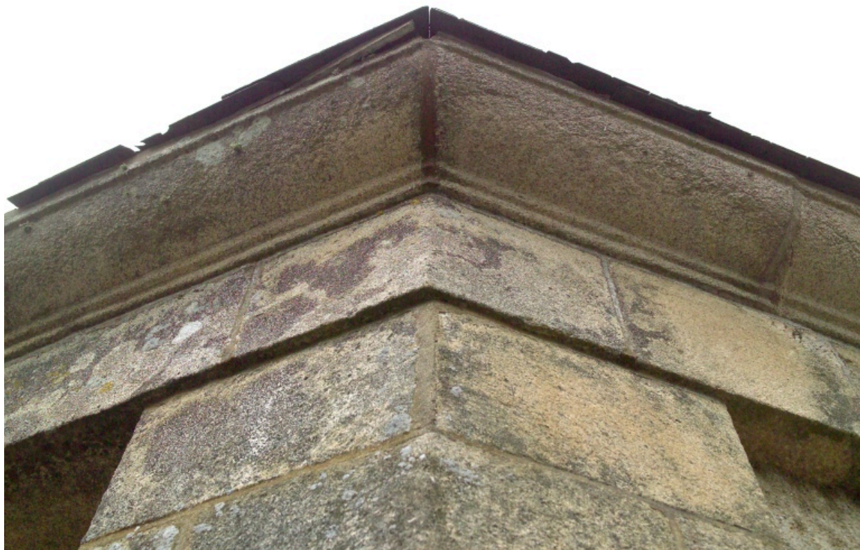
Mausolée des prêtres dit temple (détail).
