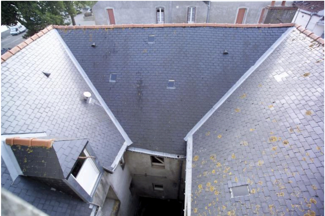
Vue de la cour depuis l'escalier de l'immeuble mitoyen à l'ouest n° 60.
