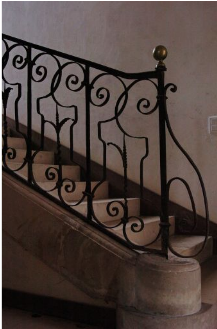
Le logis, escalier monumental : rampe en fer forgé.
