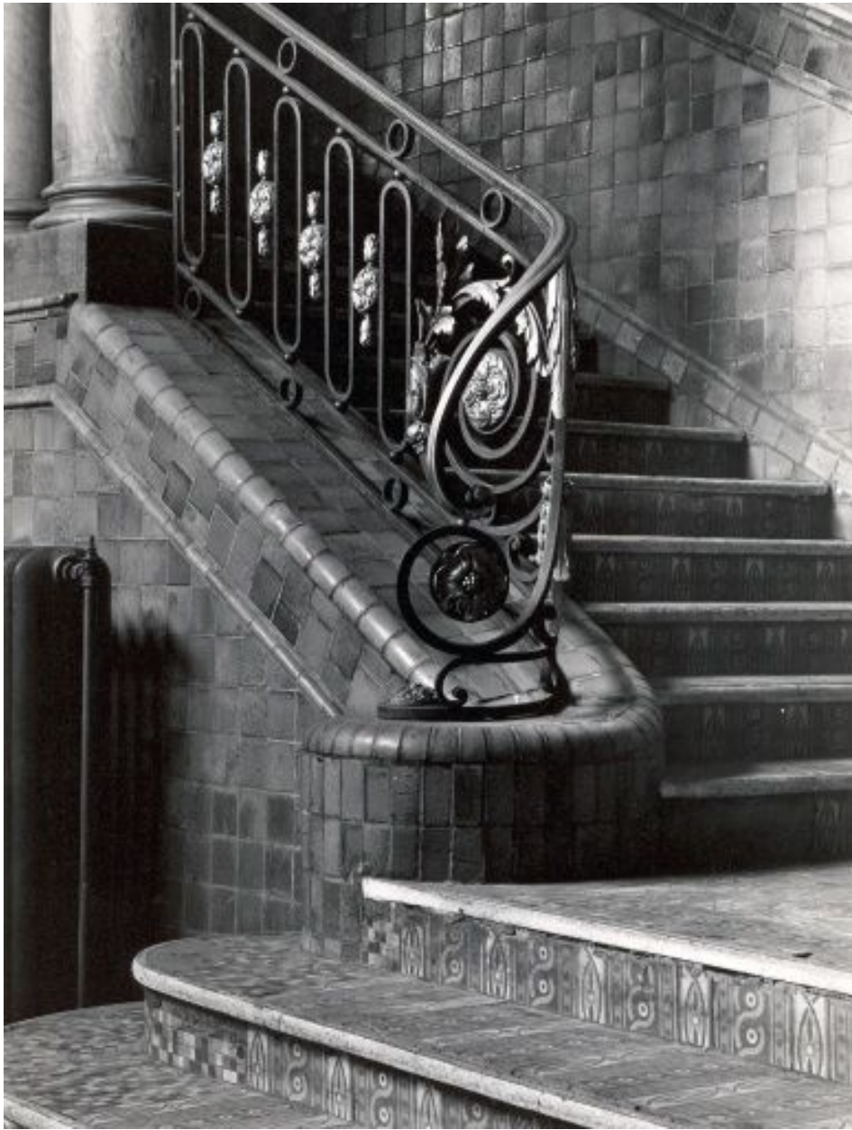
Vestibule, détails de l'escalier d'honneur.
