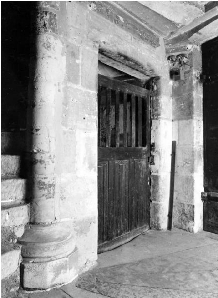
Cage de l'escalier, rez-de-chaussée : base de la vis et porte d'accès à l'étage de soubassement.
