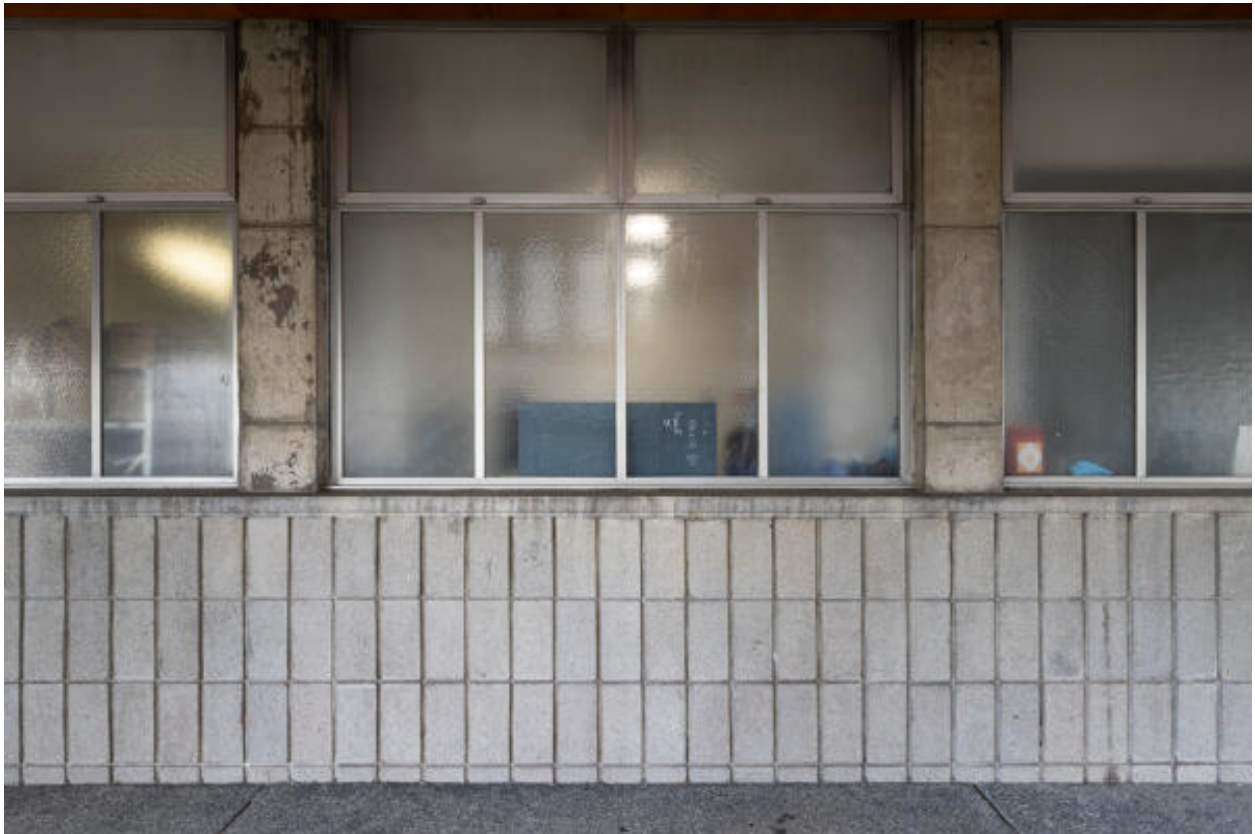
Vue du rez-de-chaussée de la façade ouest de l'aile est du lycée.
