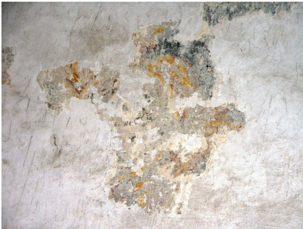
Chœur, mur sud : détail d'un écu de litre.
