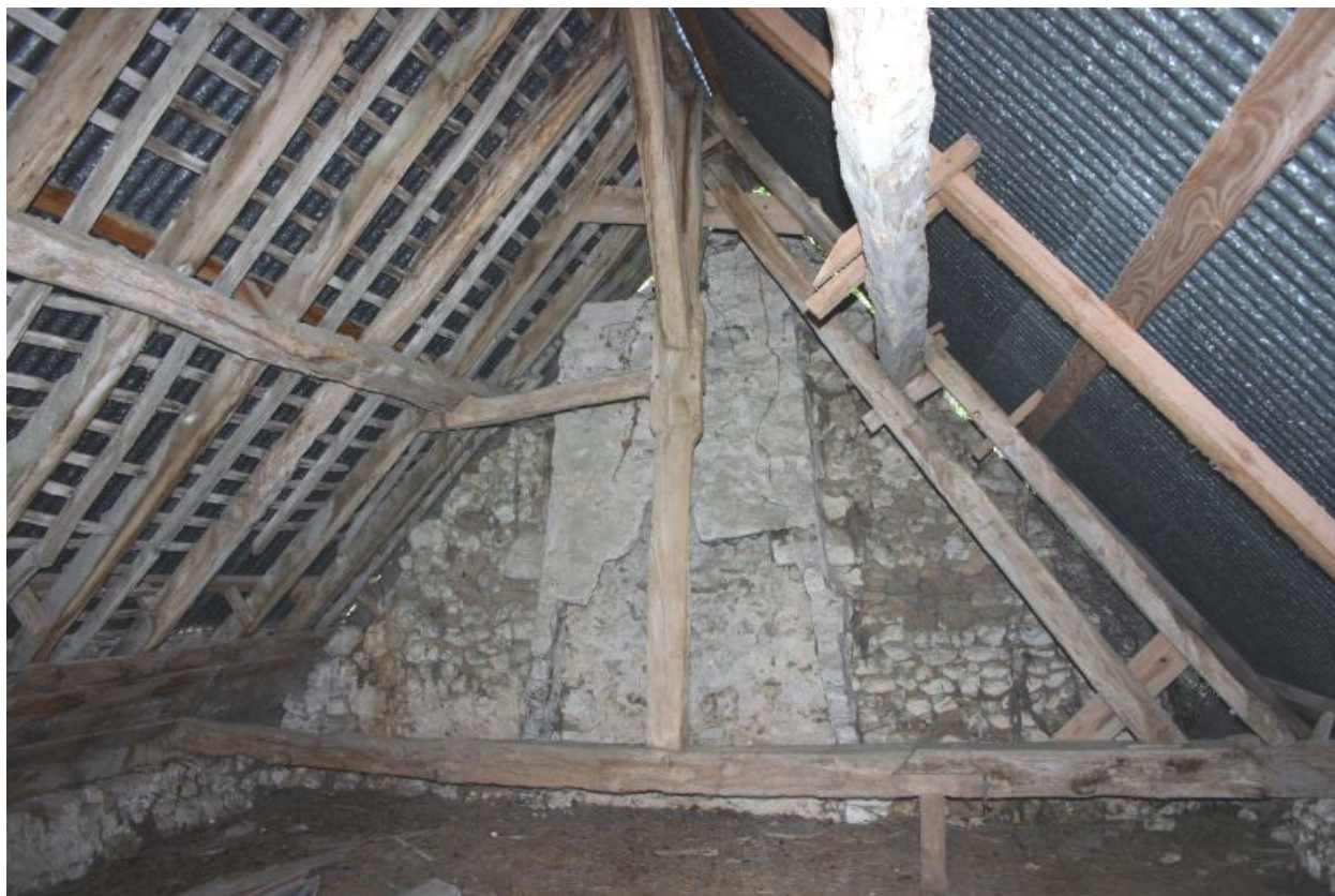
Maison 2 : charpente et hotte de la cheminée.
